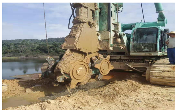
> 图1 液压铣削机搅拌防渗墙施工机具
